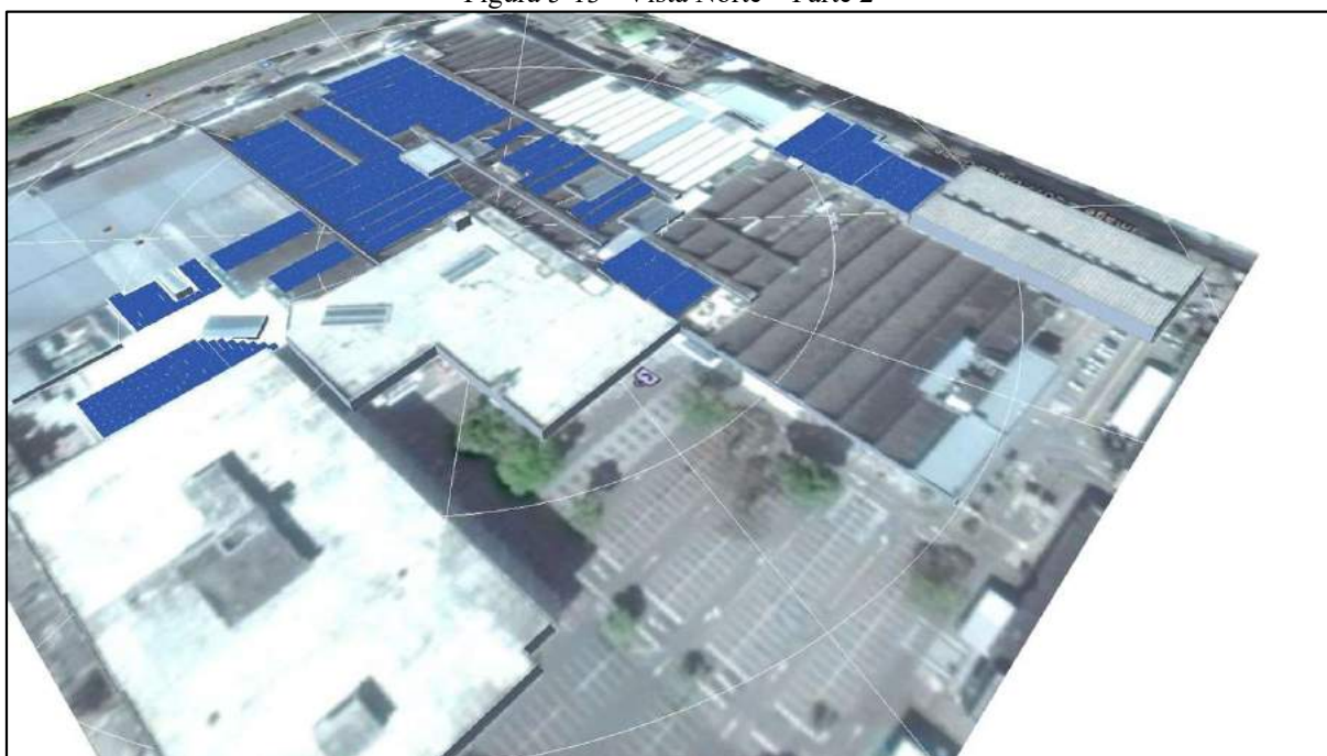
Figura 5-13 - Vista Norte – Parte 2
