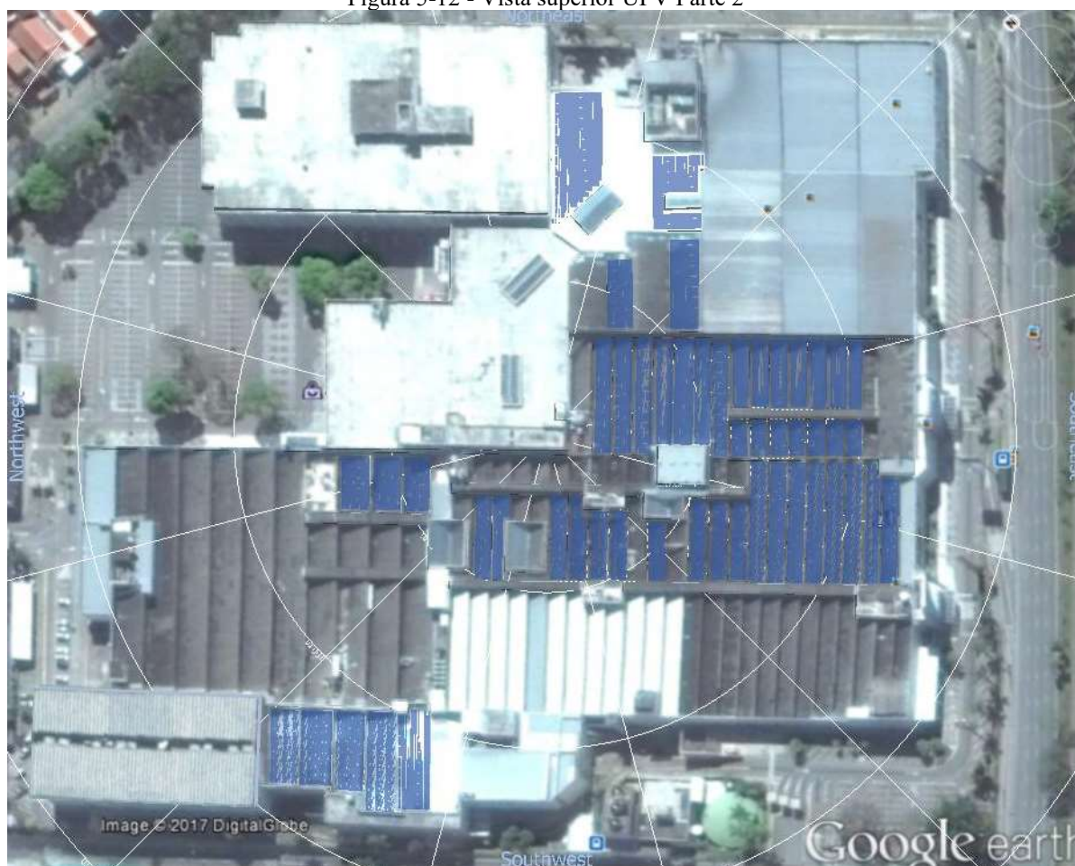
Figura 5-12 - Vista superior UFV Parte 2
